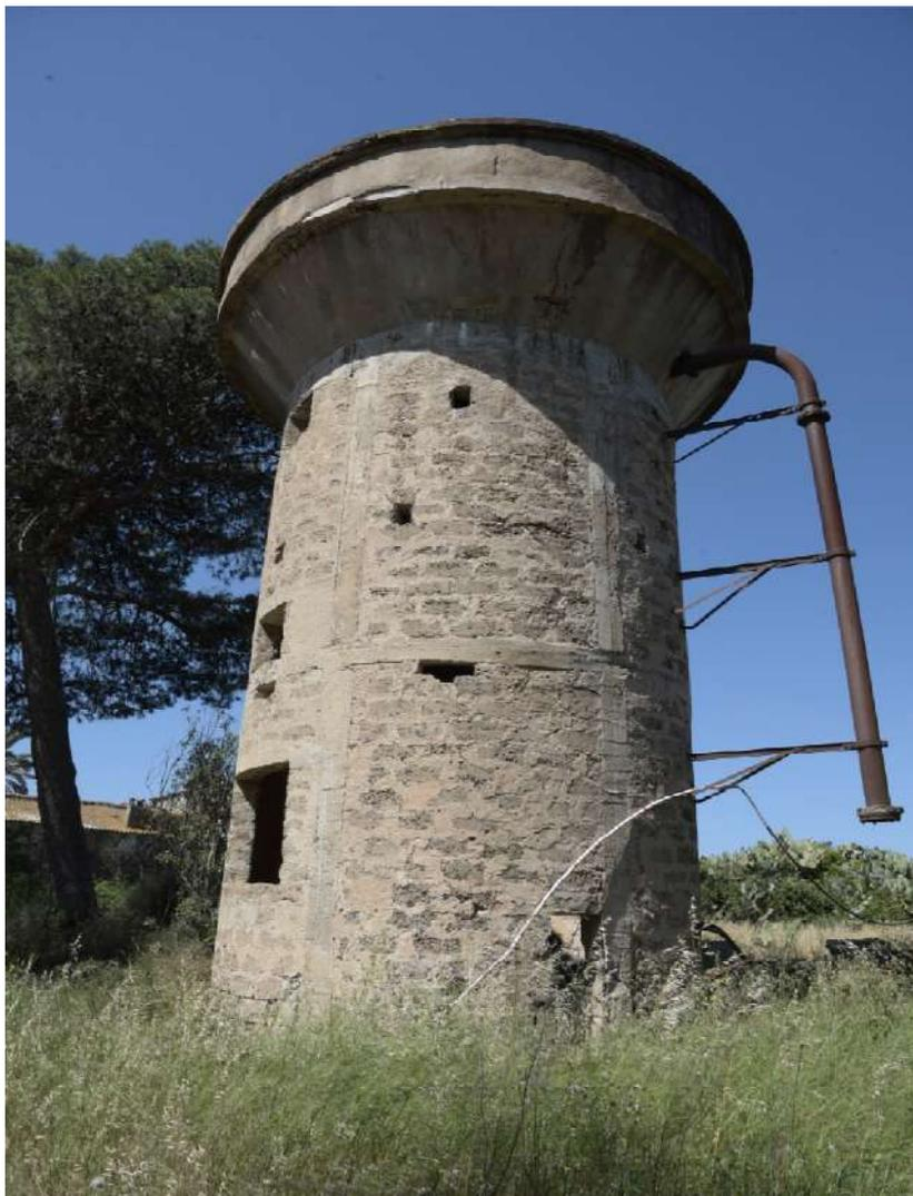
5. SERBATOIO DELL'ACQUA REALIZZATO CON MURATURA IN TECNICA MISTA PIETRA E CEMENTO
