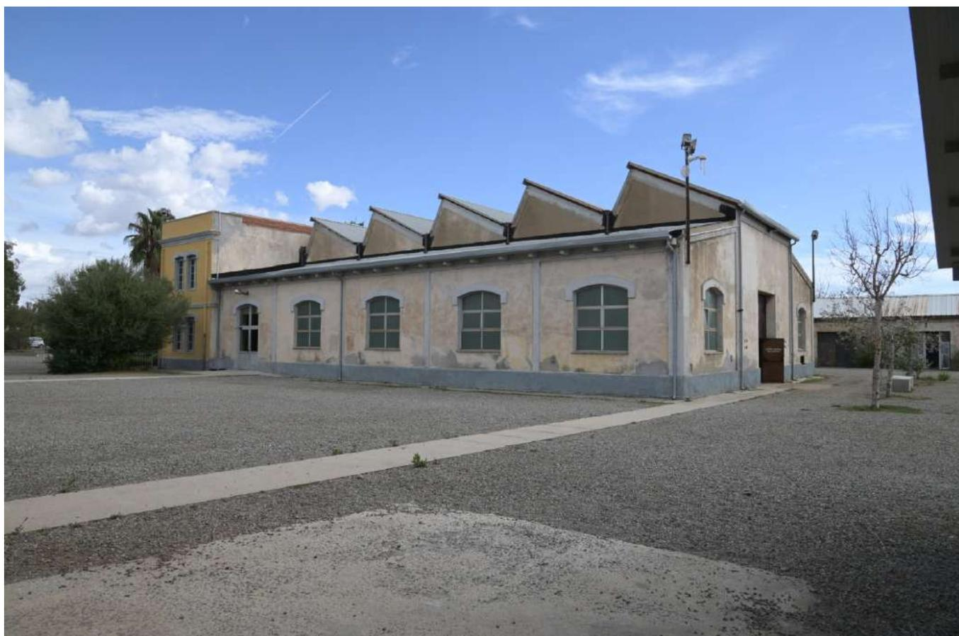
8.VISTA DEL PROSPETTO LATERALE DELLE OFFICINE CON COPERTURA REALIZZATA CON TIPOLOGIA A “SHED”. ARCHIVIO FOTOGRAFICO SOPRINTENDENZA. FOTO G. PINTORI
