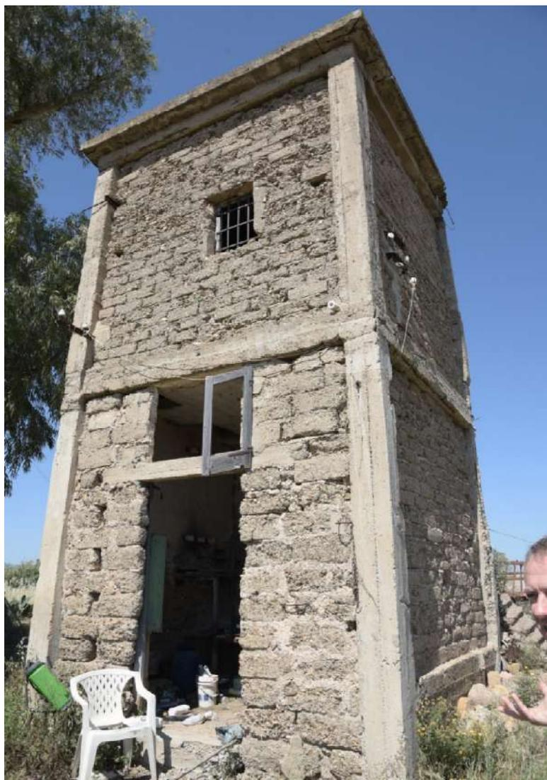
6. CABINA ELETTRICA REALIZZATA CON TECNICA MISTA IN MATTONE CRUDO E CEMENTO ARMATO. ARCHIVIO
